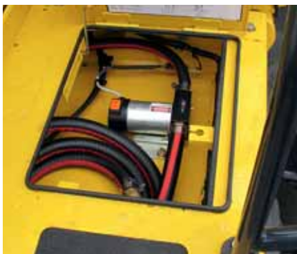
Pompe de réapprovisionnement électrique
